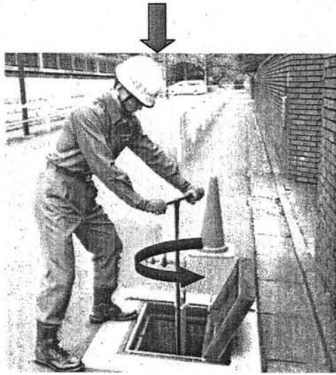
スピンドルドライバーを反時計回り（左回り）に回して水が出るか確認します。スタンドパイプから水が出るのを確認したら、スピンドルドライバーを時計回り（右回り）に回して水を止めます。なお、弁を開く時は周囲の安全をよく確認しましょう。急激な操作は大変危険です。
