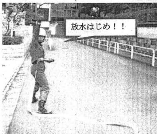
合図は、声や動作で確実に伝えます。相手が見えない場合は、誰かに伝えてもらいます。吸水操作をしている人は、合図を確認したらスピンドルドライバーを反時計回り（左周り）に回して水を出します。
