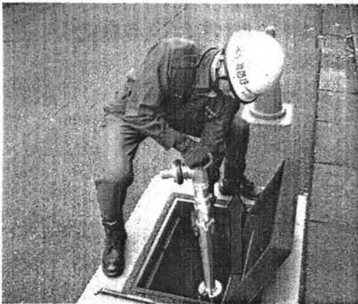
結合したら、一度上方へ引っ張り確実に接続されているか確認します。結合が不十分だと放水中に外れる可能性があり、大変危険です。
