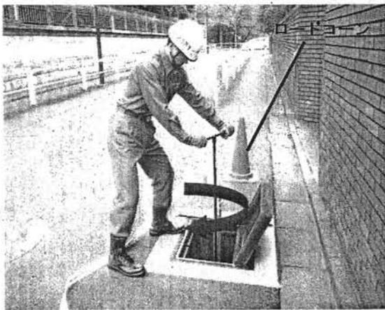
他の人が消火栓の穴の中に落ちないようにロードコーンを置くなどして注意を促します。
